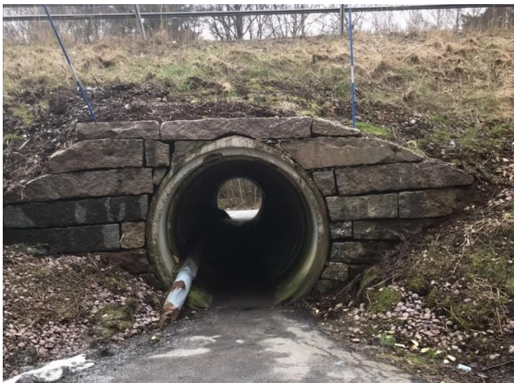
Figur 5. GC-tunnel under Länsväg 160.
